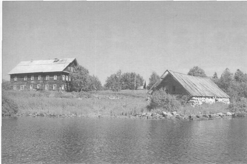
Деревянные и валунные постройки середины XIX столетия в Исаакиевском скиту
