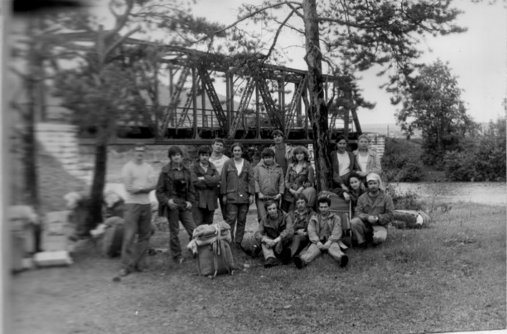
Мост через р. Катавку у г. Катав-Ивановск
