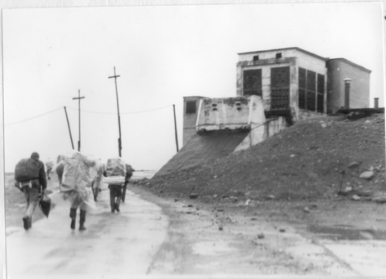
Электростанция в долине р. Ворт- квуду
