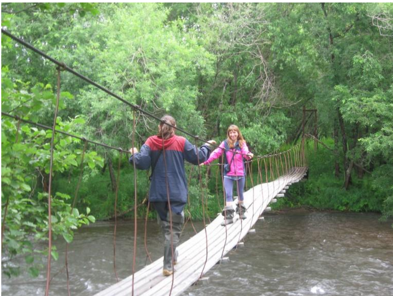
76. 31.07 Пешеходный мост через реку Пиначевская
