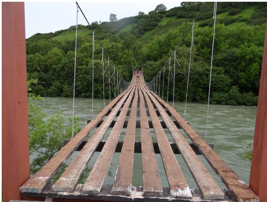
Фото 16 – Мост через реку Озёрная
