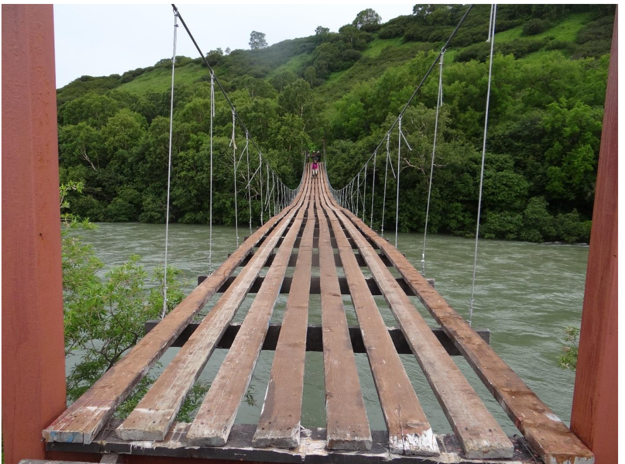
Фото 16 – Мост через реку Озёрная
