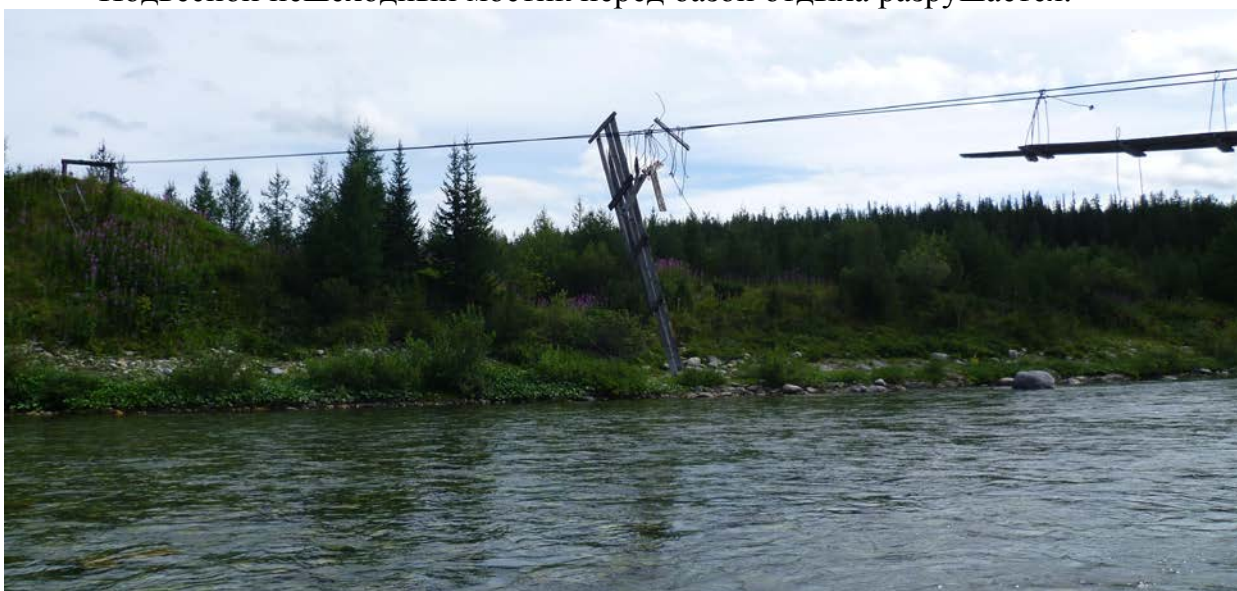
Подвесной пешеходный мостик перед базой отдыха разрушается.
