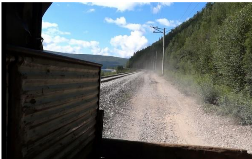
Фото 1. Дорога вдоль насыпи БАМа
